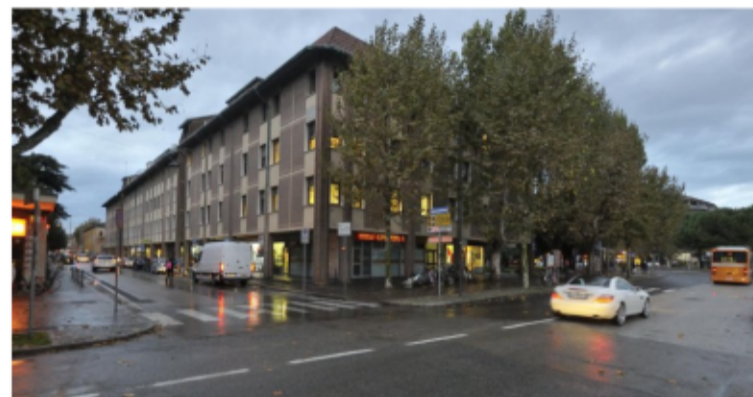
L'edificio di viale Farini che diventerà studentato FOTO FIORENTINI
